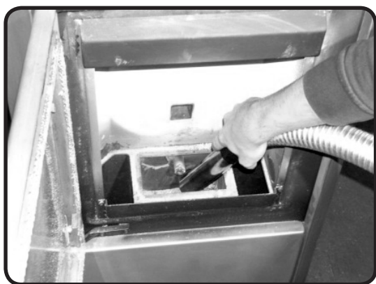
Abb. 14f: Reinigung Brennraumbehälter
