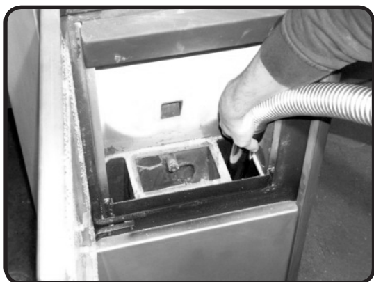
Abb. 14g: Reinigung untere Brennkammer
